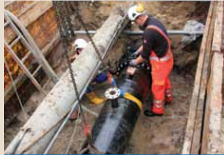
Asennettaessa ahtaisiin kaivantoihin
